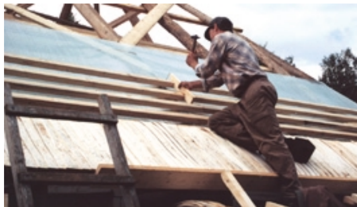
Roovitise lõõmine roovi šablooniga.
